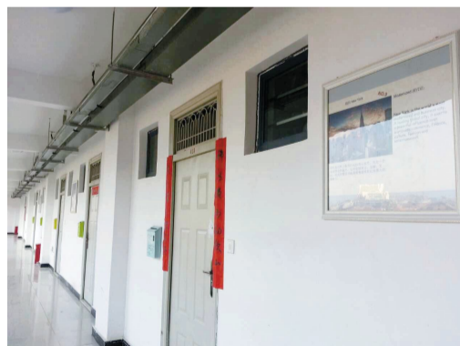
挂满国外异域风景照的宿舍走廊
